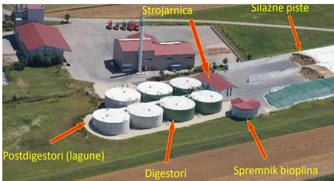
Slika 28. Bioplinsko postrojenje
