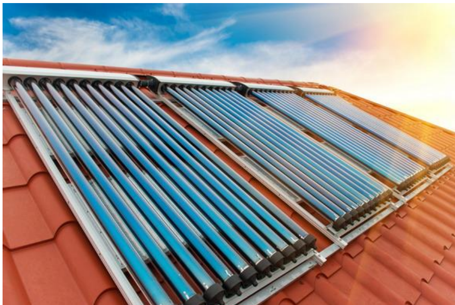
Slika 35. Instalacija solarnih kolektora na krovu
