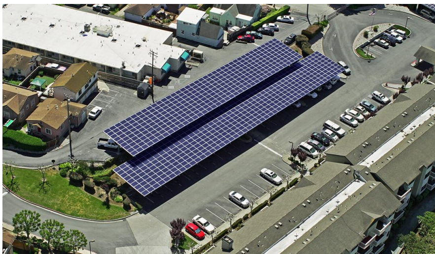
Slika 31. Primjer sunčane elektrane na javnom parkiralištu
