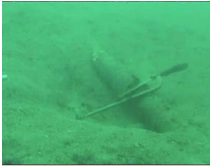
Slika 9. KB 110 kV Dugi Rat-Postira-kabel van pogona, potrebna zamjena
