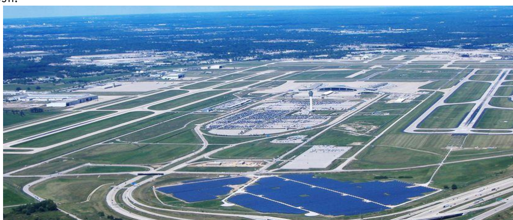
Slika 20. Primjer fotonaponske sunčane elektrane u blizini aerodroma
