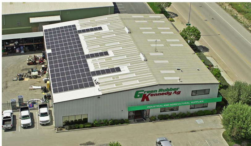
Slika 32. Primjer sunčane elektrane na krovu proizvodno-poslovne zgrade
