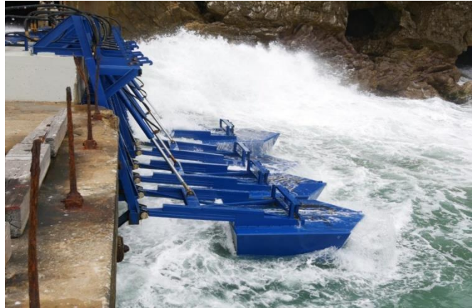
Φώτο 1: Πάρκο παραγωγής καθαρής ενέργειας αξιοποιώντας τον κυματισμό της περιοχής
