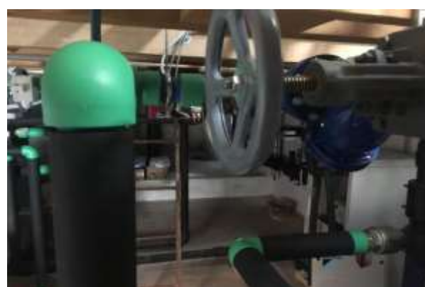
Slika 29. Dizalica topline na morsku vodu u Hvarskom kazalištu IZVOR: Fotografije grada Hvara
