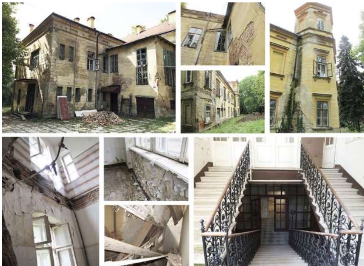
Slika 26. Dvorac Bračak prije obnove IZVOR: www.bracak.croenergy.eu
