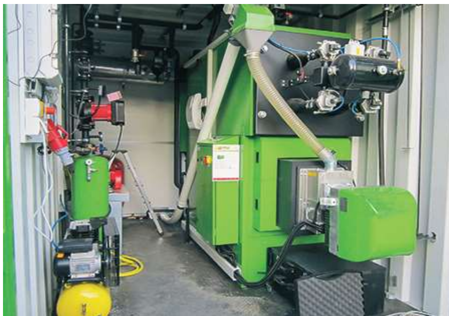
Slika 28. Kotao na biomasu s automatskim punjenjem IZVOR: www.energetika-net.com
